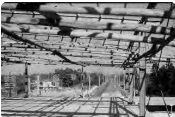
階上から小山方面を見た風景
