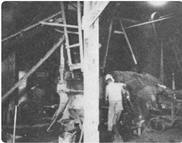
→昭和7年当時の作業風景
