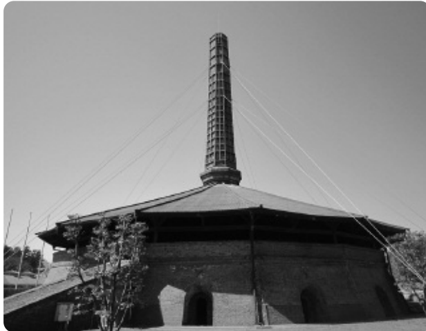
→修復工事着工前(平成21年4月)の野木町煉瓦窯
