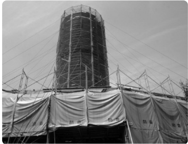
→現在の野木町煉瓦窯(修復工事中)
