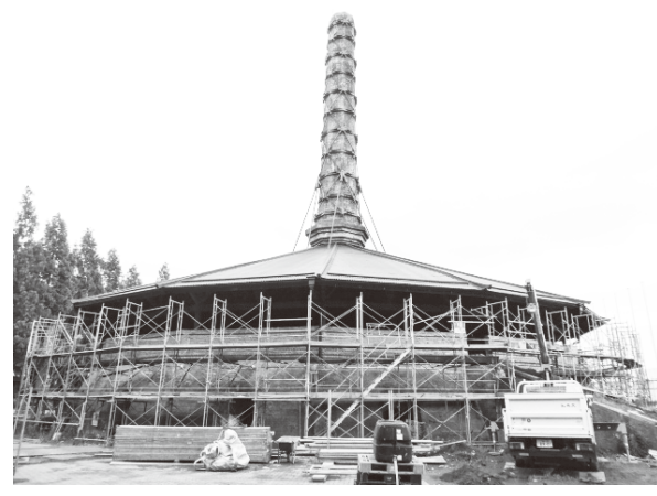
まもなく改修工事完了…野木町煉瓦窯
