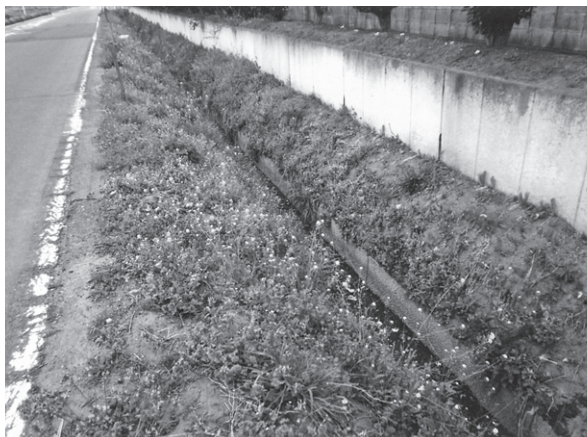
転落事故が起きた用水路付近
