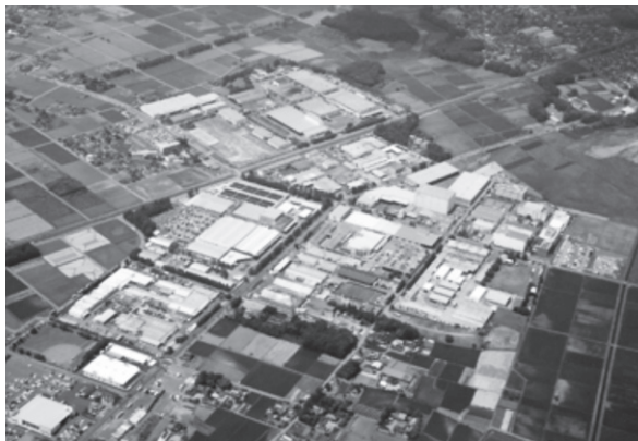
野木工業団地の北部に新産業団地を造成
