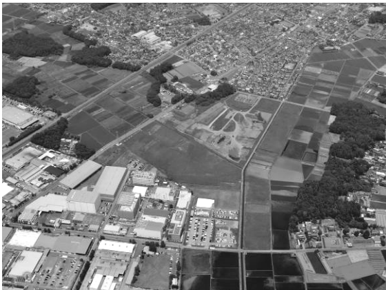
□ 野木第二工業団地
