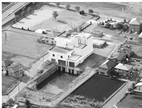
□ 逆川排水機場
