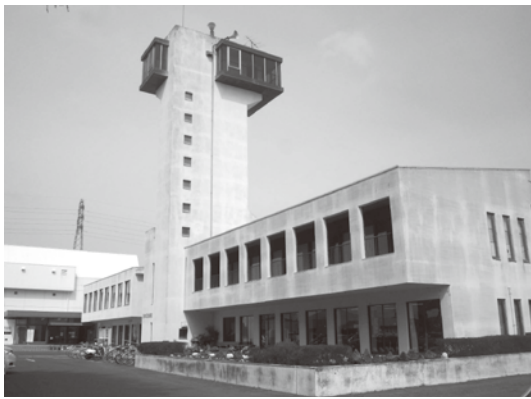
解体間近な野木町公民館望楼
