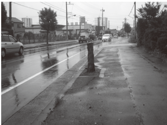
伐採したままとっている街路樹
