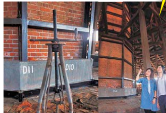
専用の器具を使ってダンパーの開閉を行った
