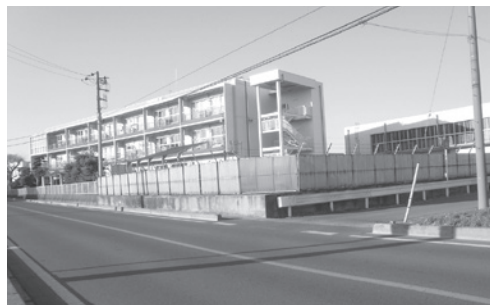
錆が広がるプール外周フェンス(友沼小学校)
