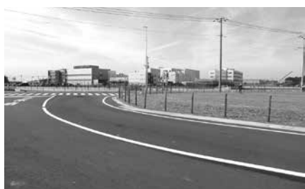
第2工業団地内に新設された道路
