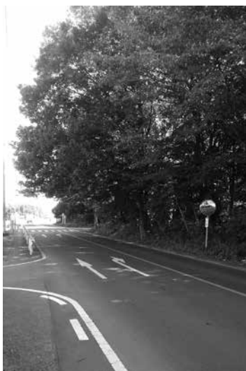
道路にはみ出した危険な樹木
