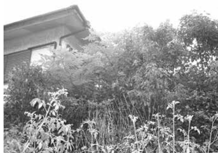
管理されていない空き家 (隣家の庭に覆いかぶさるような樹木)
