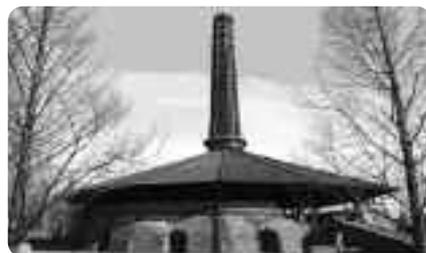
ホフマン式輪窯は、銀座煉瓦街建設に際し日本に導入されてから各地に築造され、昭和26年(1951)には全国で50基存在していたということですが、現在残るホフマン式輪窯は、野木町煉瓦窯(国指定重要文化財「旧下野煉化製造会社煉瓦窯」)を含めわずか4基のみです。また、残る4基の中でも野木町煉瓦窯は、最も古く、最も原形をとどめているため各方面からの評価の高いものです。
