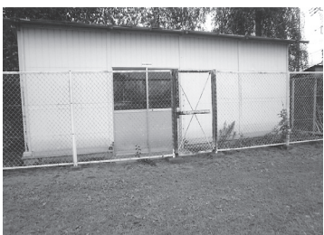
野木原水位観測所
