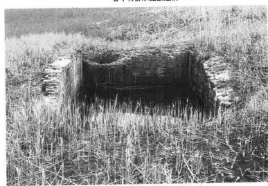
排水施設遺構 (明治27年頃造られた)
