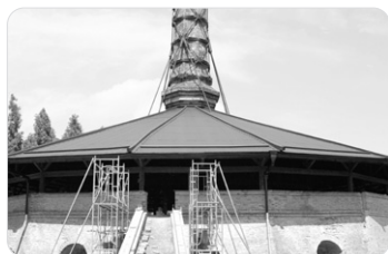
現在修復中の野木町煉瓦窯
