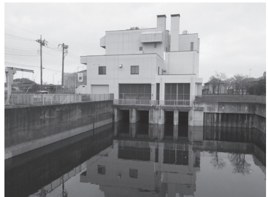
逆川排水機場（沈砂池）
