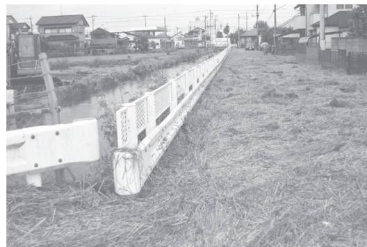
逆川に流入した稲藁（排水機場東）
