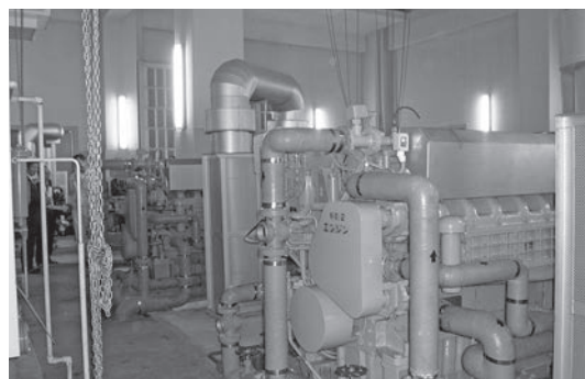
逆川排水機場内部の視察
