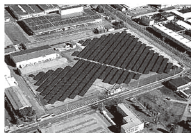
←メガソーラー発電所
