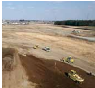
造成が進む第二工業団地
