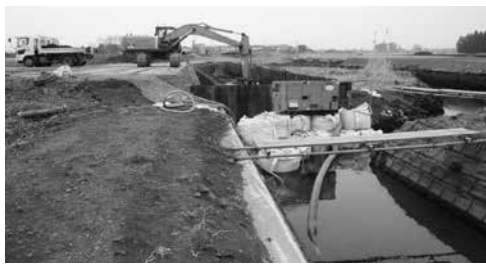
野木第二工業団地造成工事
