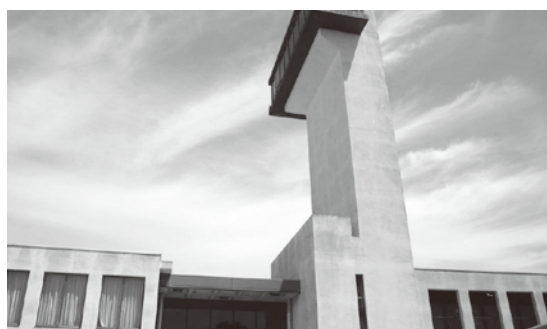
解体・撤去される野木町公民館望楼
