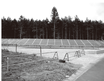
山林を伐採して設置された太陽光パネル
