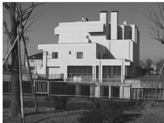
□ 逆川排水機場
