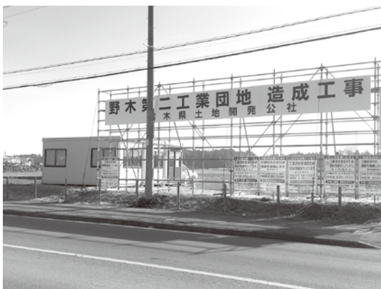
工事が進む第二工業団地整備
