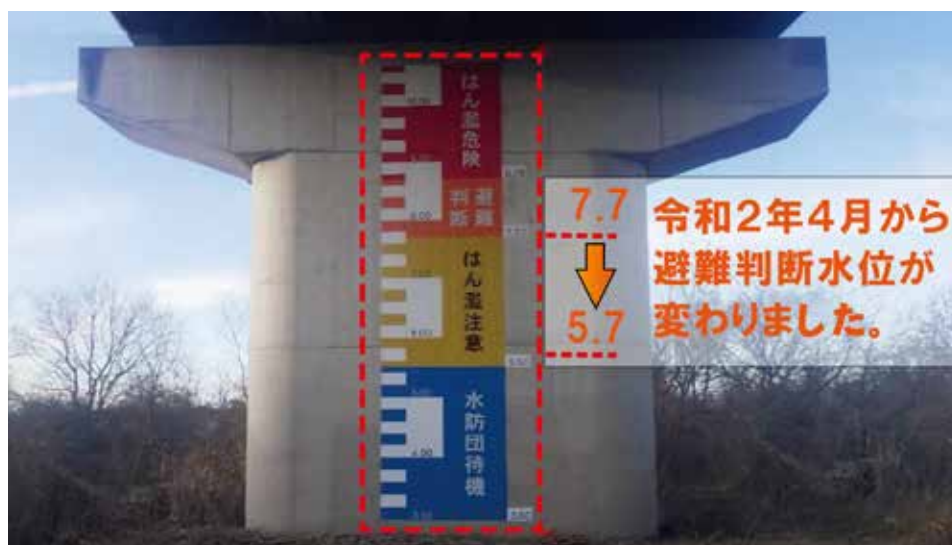
▲松原大橋の橋げたに示された水位の目安
