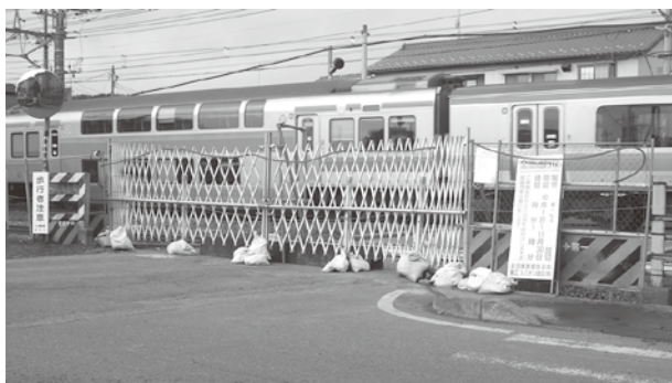
通学路である第一松原踏切拡幅工事 (令和2年度完成予定)
