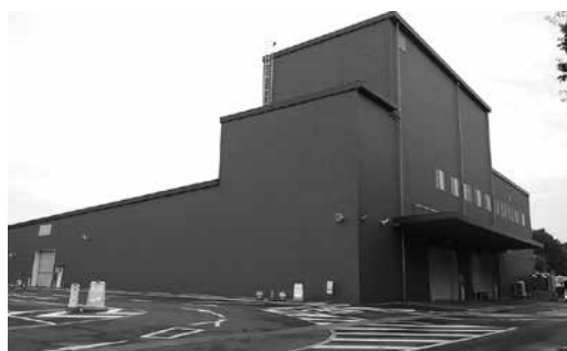
生ゴミを処理する南部清掃センター（野木町）
