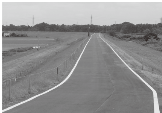
思川右岸の堤防拡張工事の完成写真
