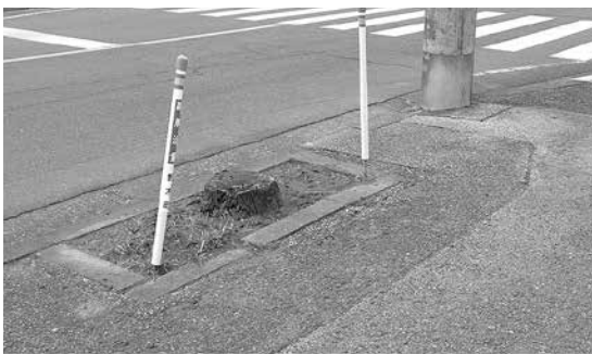
切り株が残った状態の植樹桝
