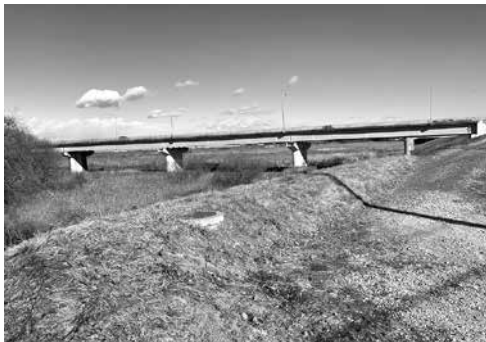
松原大橋左岸下流の盛土箇所 (土のうを積んだ場所)
