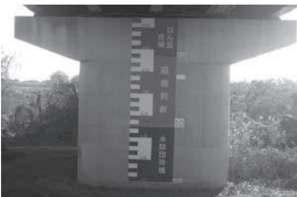
▲松原大橋の橋脚
