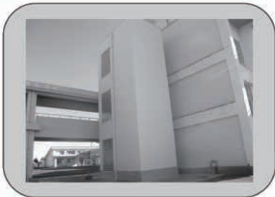
野木第二中学校にエレベーターを新設
