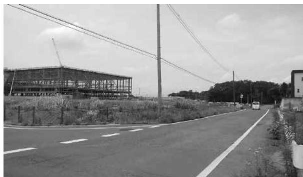
建設中の立地企業と住宅団地（撮影：市民農園東端）
