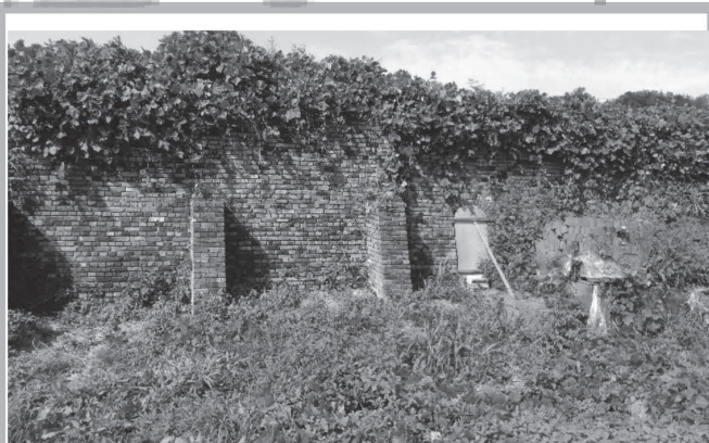
※旧中川煉瓦製造所ホフマン窯 (滋賀県近江八幡市)
