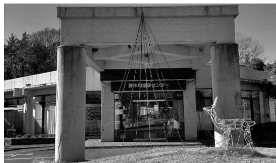
建設から28年が経過した「ゆ〜らんど」
