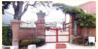
K 古河市 a 古河第一小学校旧正門
