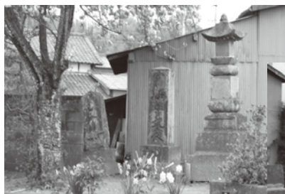
傾いた地蔵様(修復前)
