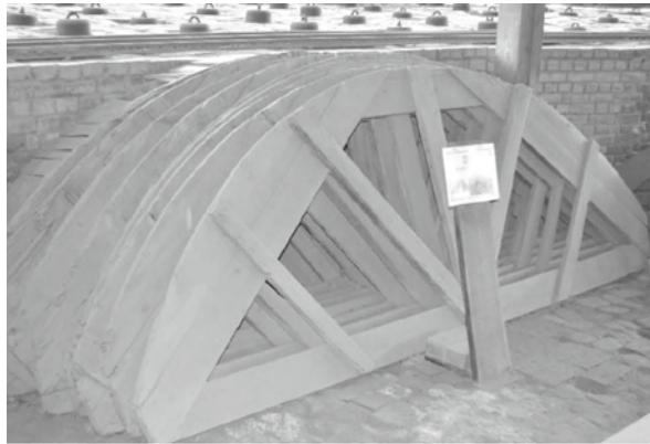
野木町煉瓦窯2階の型枠
