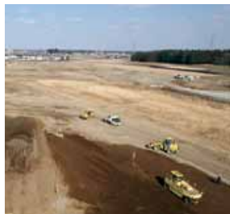
造成が進む第二工業団地
