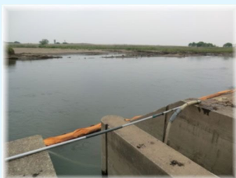
取水口(野木町大字野木)
