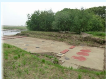
取水路(野木町大字野木)
