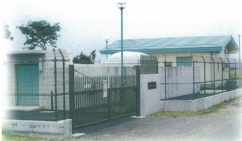
川西配水場(野木町大字友沼)
