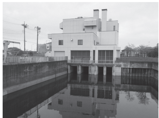
逆川排水機場（沈砂池）
