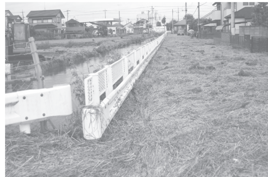
逆川に流入した稲藁（排水機場東）
