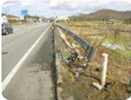
ガードレール・ 標識等の損傷
