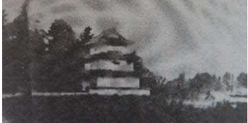
明治2 古河城3階櫓（古河市）
