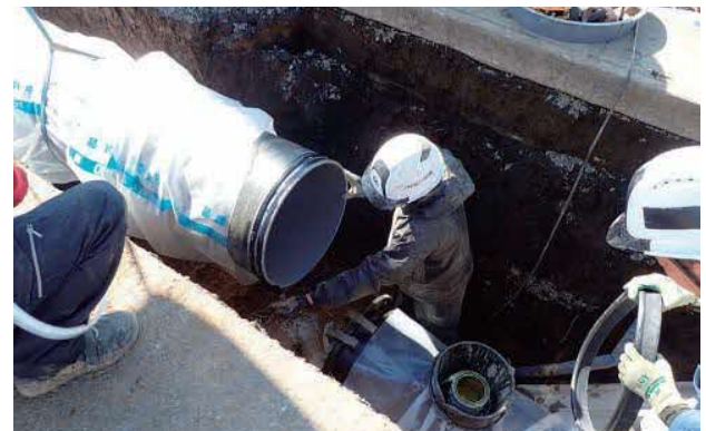
水道管の更新工事
