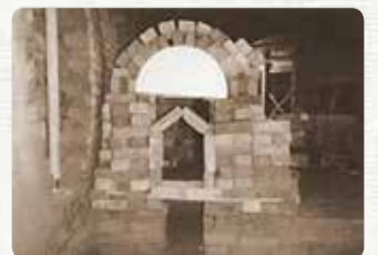
焚き口(ロストル) 仮組の様子
